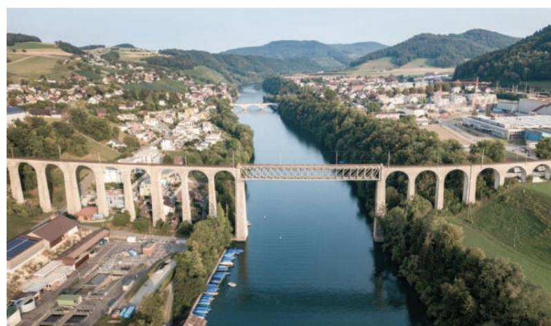
Die gemauerte Bogen-Konstruktion hat eine viel höhere Signifikanz und dadurch ortsspezifische Bedeutung als die eigentliche rheinüberquerende Stahlträgerkonstruktion. Letztere müsste im Rahmen des Doppelspurausbaus eh abgebrochen, neu entworfen und gebaut werden.
